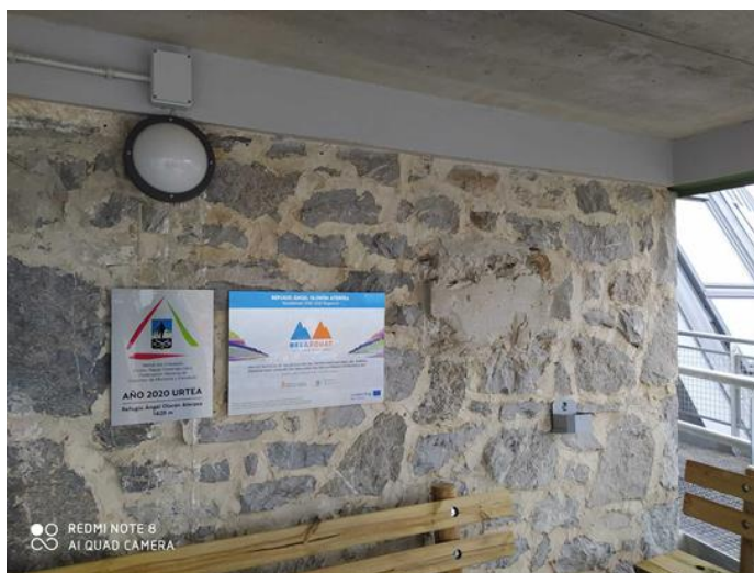
Figura 9. Un exemple de plaque ou de clôture permanente sur une infrastructure.
